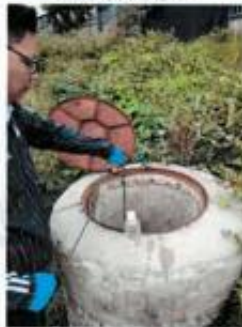
生活污水排放口
